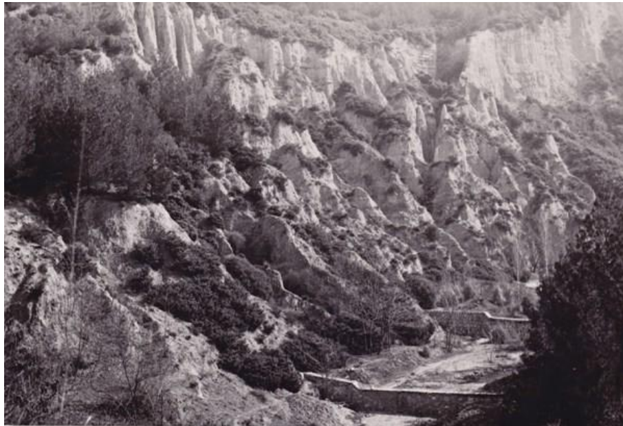
Εικόνα 13. Διαδοχικά φράγματα χειμάρρου Αμμούδα Ν. Σερρών σε συνδυασμό με φυτοτεχνική διευθέτηση των έντονα διαβρωμένων πρανών, το έτος 1959 (από το αρχείο της δασικής υπηρεσίας) (Καπετανίος 2013).
